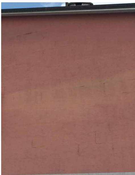
Adesivo di scarsa qualità e/o male applicato
