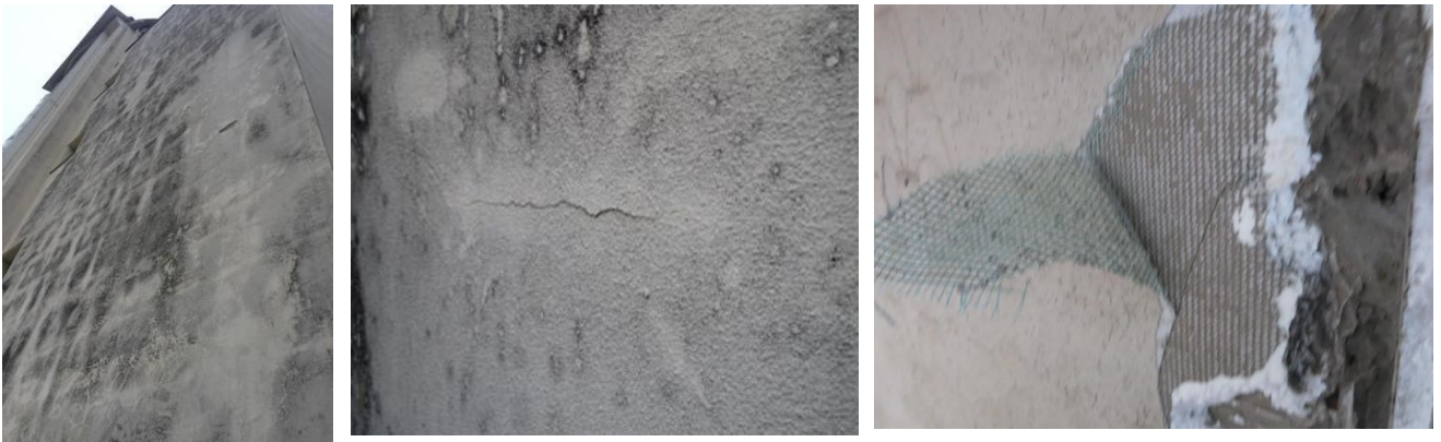
Distacco rasatura armata da pannello isolante
