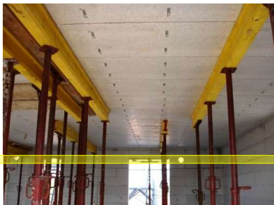
BANCHINAGGIO INFERIORE
