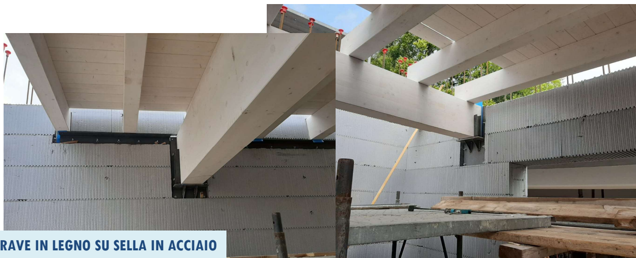
TASCHE SU ISOLANTE INTERNO PER ALLOGGIAMENTO TRAVETTI
