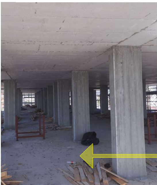
SOLAIO PORTANTE in C.A.
