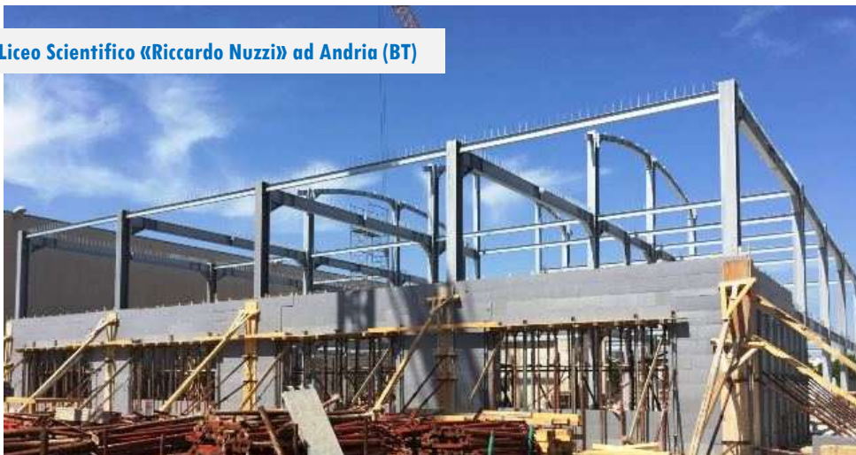
UTILIZZO DELLE PARETI ICF COME TAMPONAMENTO AD UNA STRUTTURA IN ACCIAIO
