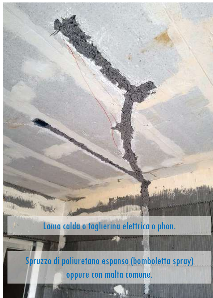
Realizzazione delle tracce e scatole di derivazione
