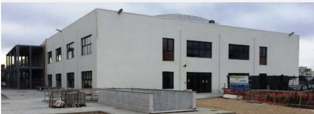
UTILIZZO DELLE PARETI ICF COME TAMPONAMENTO AD UNA STRUTTURA IN ACCIAIO
