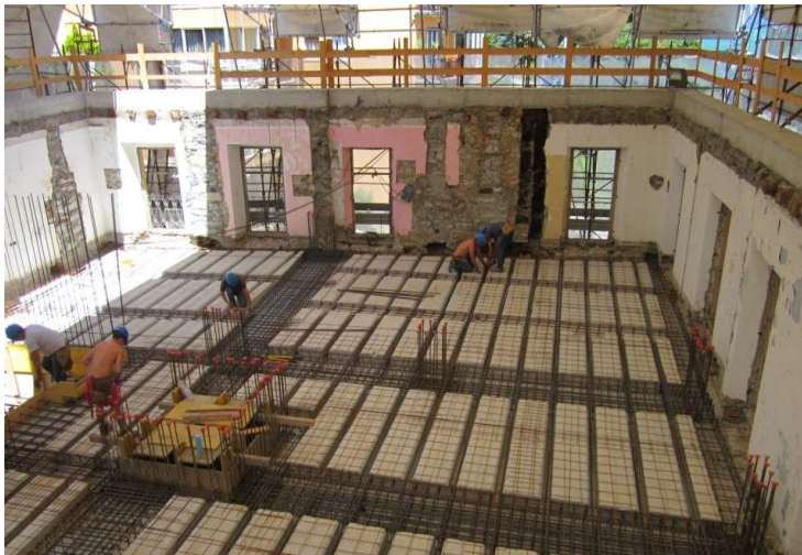
LEGGEREZZA DEL SOLAIO GETTATO
