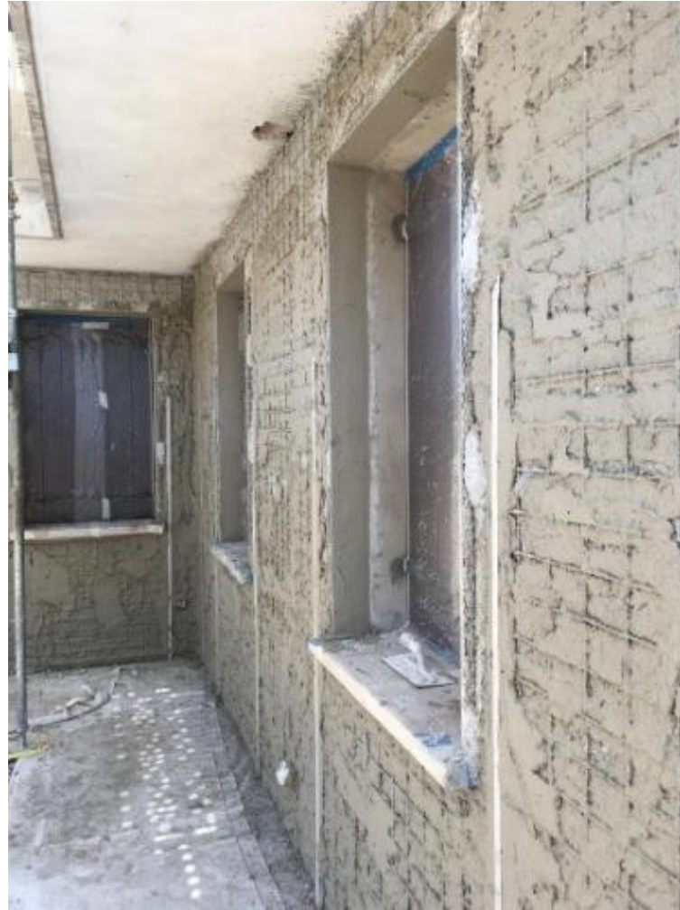
Intonacatura su Karma cappotto armato
