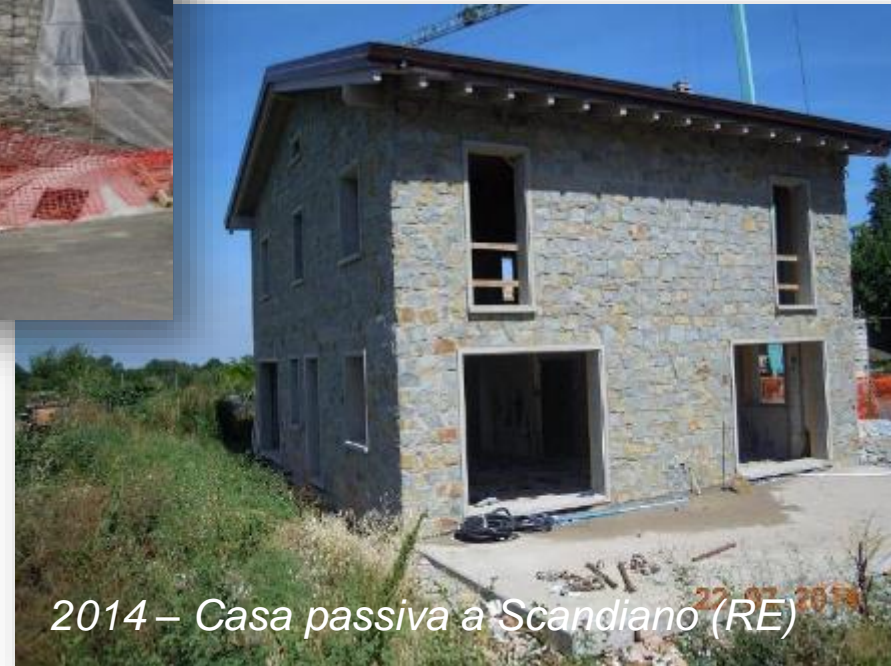
Rivestimenti in pietra e legno
