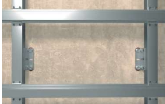
Sottostrutture in metallo
