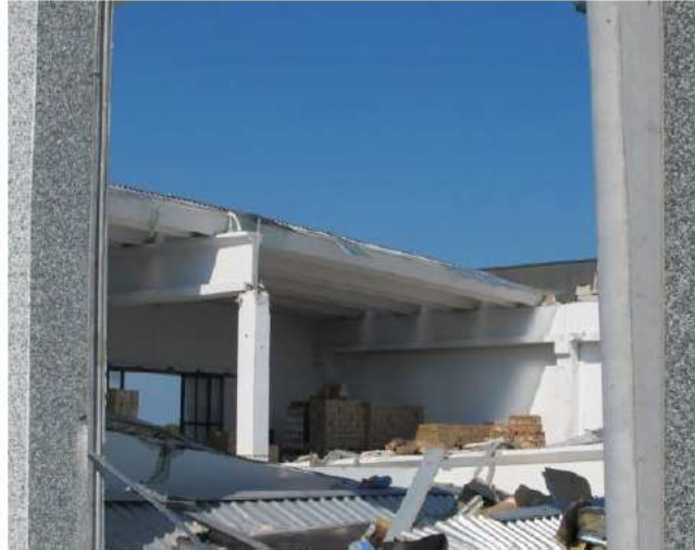
Perdita di appoggio della trave per rottura connessione in un edificio con trave principale trasversale
