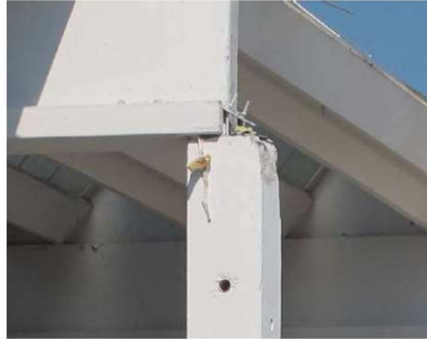
Perdita di appoggio della trave per rottura connessione in un edificio con trave principale trasversale
