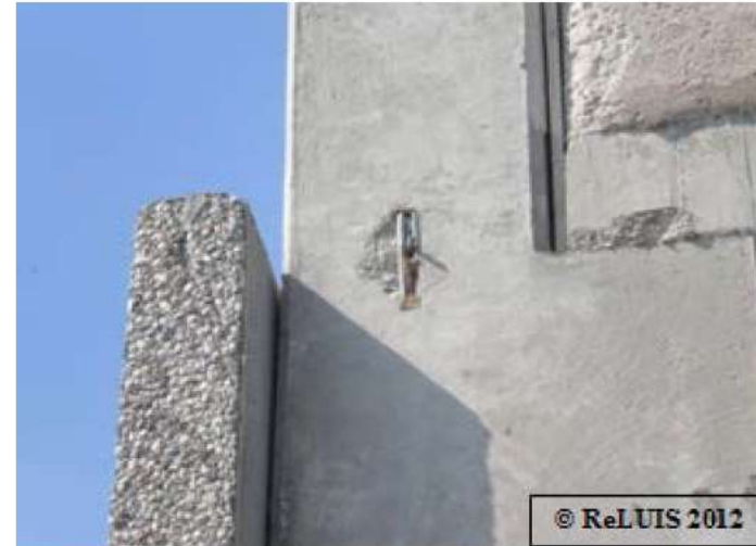
(a) Collasso pannelli orizzontali di tamponamento per (b) crisi a taglio del connettore inserito tramite apposita testa a martello nel profilo a C annegato nel pilastro
