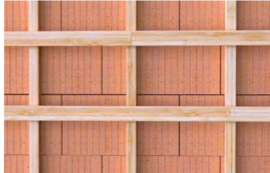
Sottostrutture in legno
