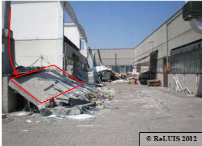
(a) Collasso pannelli orizzontali di tamponamento per (b) crisi a taglio del connettore inserito tramite apposita testa a martello nel profilo a C annegato nel pilastro
