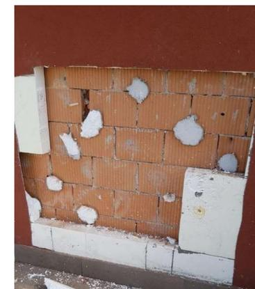
L'incollaggio a cordoli e punti blocca i bordi dei pannelli e lascia delle zone libere di poter assecondare i movimenti termoplastici senza produrre lesioni
