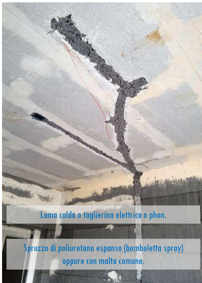
Realizzazione delle tracce e scatole di derivazione
