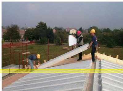
POSA DEI PANNELLI
