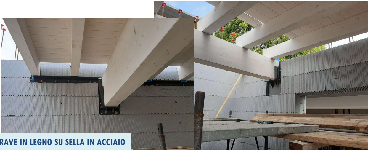
TASCHE SU ISOLANTE INTERNO PER ALLOGGIAMENTO TRAVETTI
