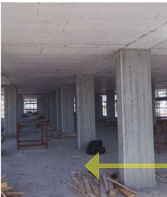
SOLAIO PORTANTE in C.A.
