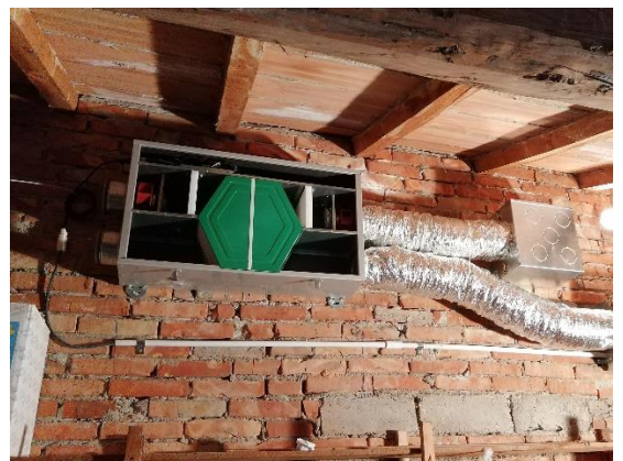
Foto di cantiere
