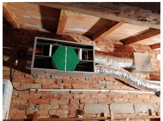
Foto di cantiere
