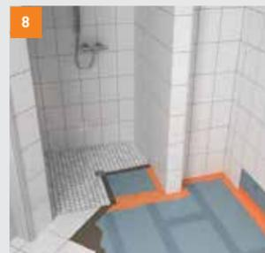
8 Nelle zone di raccordo dell'elemento di scolo Powerpanel TE, si applica il sistema impermeabilizzante
