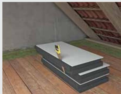
La posa avviene da destra a sinistra con posa "a correre". Per la prima fila, la battentatura sporgente sul lato lungo viene segata.
