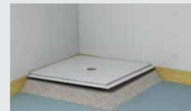
Variante A: ad altezza del bordo superiore del pozzetto, nell'area dell'elemento doccia, viene distribuito il sottofondo livellante semisecco e posato l'elemento doccia.
