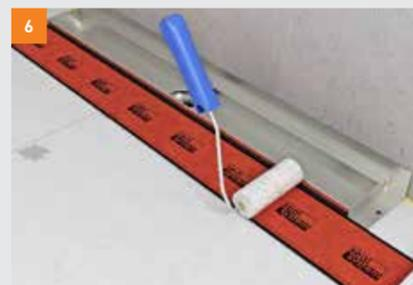
6 Applicare sul canale di scolo e sulle lastre di scarico il nastro butilico sigillante in dotazione, premere per evitare la formazione di pieghe e sovrapporre gli strati sporgenti
