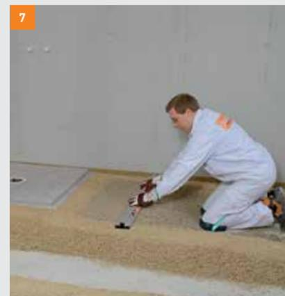
7 Una volta versato il sottofondo livellante semisecco tra le "strisce d'appoggio", spianare a misura
