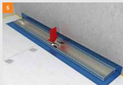
5 Incollare la porzione dello scarico (ad es. con **fermacell** Adesivo per giunti), quindi posizionare il canale di scarico e verificare con le dita che sia stato inserito correttamente nella piletta.
