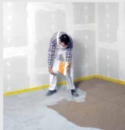
Posare **fermacell** Riempimento granulare pesante per nido d'ape
