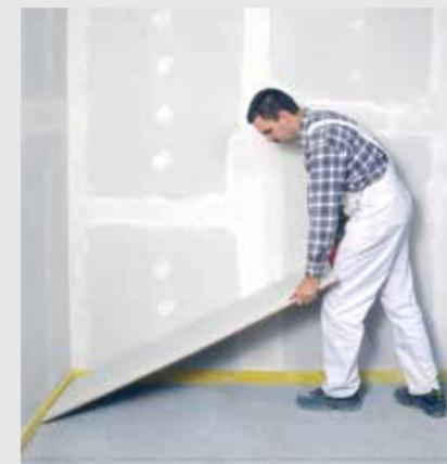
Posare le lastre per sottofondi **fermacell**
