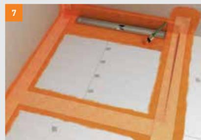
7 Sigillare i raccordi tra elementi costruttivi adiacenti, ad es. incollando con la guaina liquida sigillante **fermacell** le guarnizioni per angoli e spigoli **fermacell** e, tutt'attorno, il nastro elastico sigillante **fermacell**. Quindi impermeabilizzare tutta l'area dello scarico (doppia applicazione di **fermacell** Guaina liquida sigillante).
