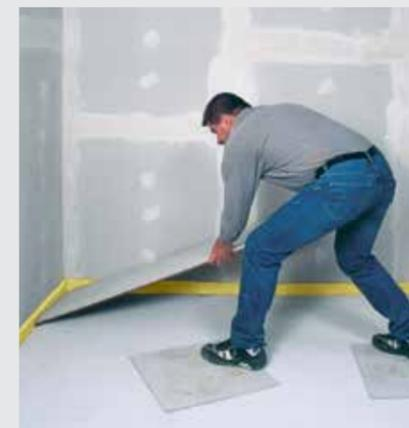
Posa delle lastre per sottofondi **fermacell** sul livellante granulare leggero **fermacell**
