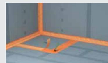
Quando le lastre per sottofondo Powerpanel TE sono posate, incollate e avvitate, l'intera superficie viene passata con **fermacell Primer** concentrato e nei punti di raccordo viene impiegato il sistema di impermeabilizzazione.
