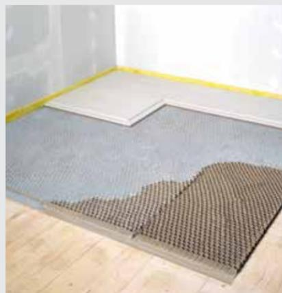
**fermacell** Sistema isolante per sottofondi con nido d'ape
