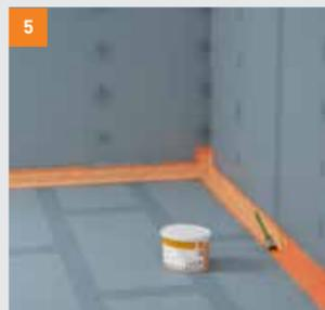
5 Immediatamente dopo, annegare il nastro elastico con un nuovo strato di guaina liquida sigillante **fermacell**
