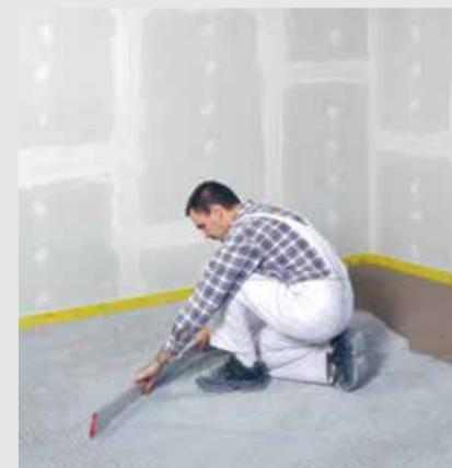
Livellare a raso del nido d'ape il riempimento granulare pesante **fermacell**
