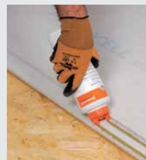
Applicare l'adesivo per sottofondi **fermacell** sulla battentatura
