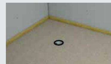
Variante B: il sottofondo livellante semisecco viene distribuito su tutta la superficie ad altezza del bordo superiore del pozzetto e successivamente si posa l'elemento doccia.
