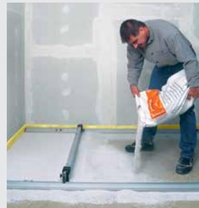
Riempimento con il livellante granulare leggero **fermacell**
