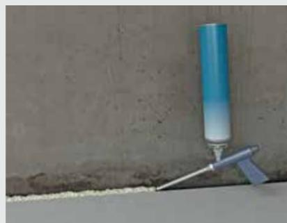
Una volta terminata la superficie, chiudere i giunti perimetrali e di raccordo (ad es. con della schiuma riempitiva) per evitare la formazione di ponti termici.
