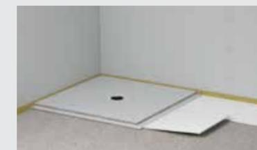
Variante B: per arrivare all'altezza della battentatura sporgente, sulla superficie viene posato un materiale isolante di 10 mm di spessore (EPS DEO 150).
