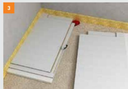
3 Posizionare il primo elemento di scarico, applicare l'adesivo per sottofondi **fermacell** sulla battentatura, congiungere i due elementi di scarico e avvitarli tra loro.
