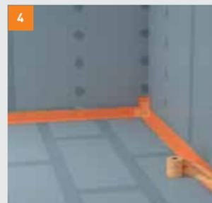
4 Comprimere il nastro elastico sigillante **fermacell** nella guaina liquida
