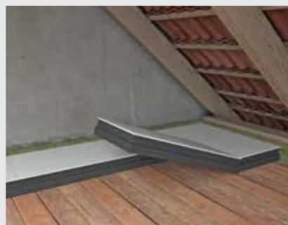
Con il pezzo avanzato dalla prima fila, proseguire con la seconda. Si dovrà rispettare uno sfalsamento dei giunti di almeno 200 mm (i giunti incrociati non sono ammessi).
