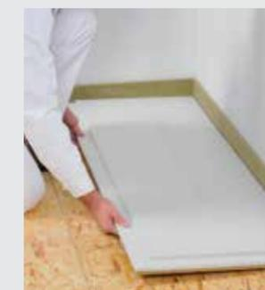
Posare **fermacell** Lastre per sottofondi
