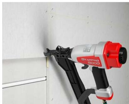
Fissaggio strato aggiuntivo pannelli in gessofibra fermacell® o Powerpanel H<sub>2</sub>O. I giunti sono contestualmente trattati con Adesivo per giunti fermacell®
