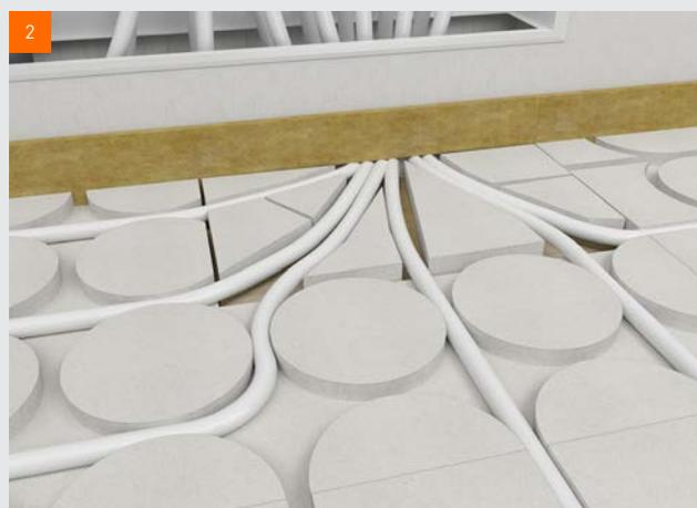
Lasciare aperto e completare con pezzi di riempimento con ritagli di lastre di gesso-fibra fermacell®.
