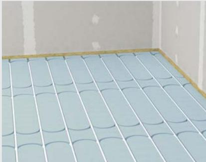
Posa dei tubi del riscaldamento a pavimento da 16 mm
