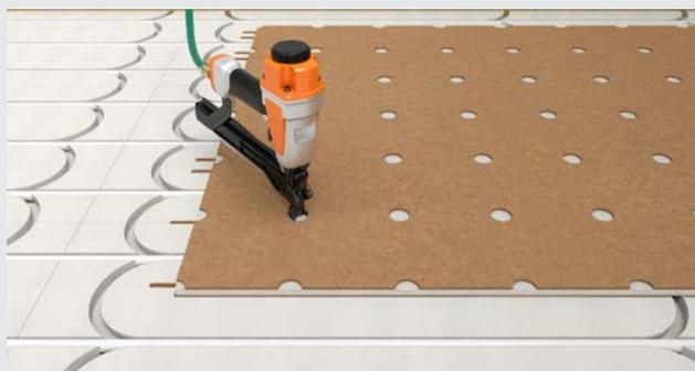
Installare il pannello di copertura e fissarlo meccanicamente con viti o punti metallici (graffe a punta divergente) utilizzando la dima.
