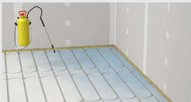
Primerizzazione degli elementi fermacell® Therm25™ con fermacell™ Primer concentrato
