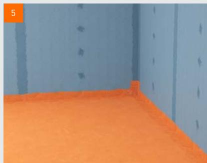
5 Sigillatura completa della superficie nell'area di esposizione possibile e deposito dell'acqua
