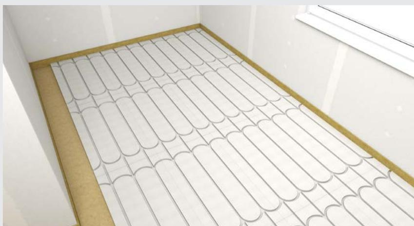
Dopo la posa dei tubi del riscaldamento a pavimento, questi devono essere messi in pressione con acqua, in modo da poter verificare la tenuta del sistema di riscaldamento a pavimento. Si può quindi procedere alla posa della lastra di gesso-fibra fermacell® aggiuntiva (spessore in funzione dell'area di applicazione). Questo strato viene posato in aderenza con uno sfalsamento dei giunti di > 167 mm rispetto
