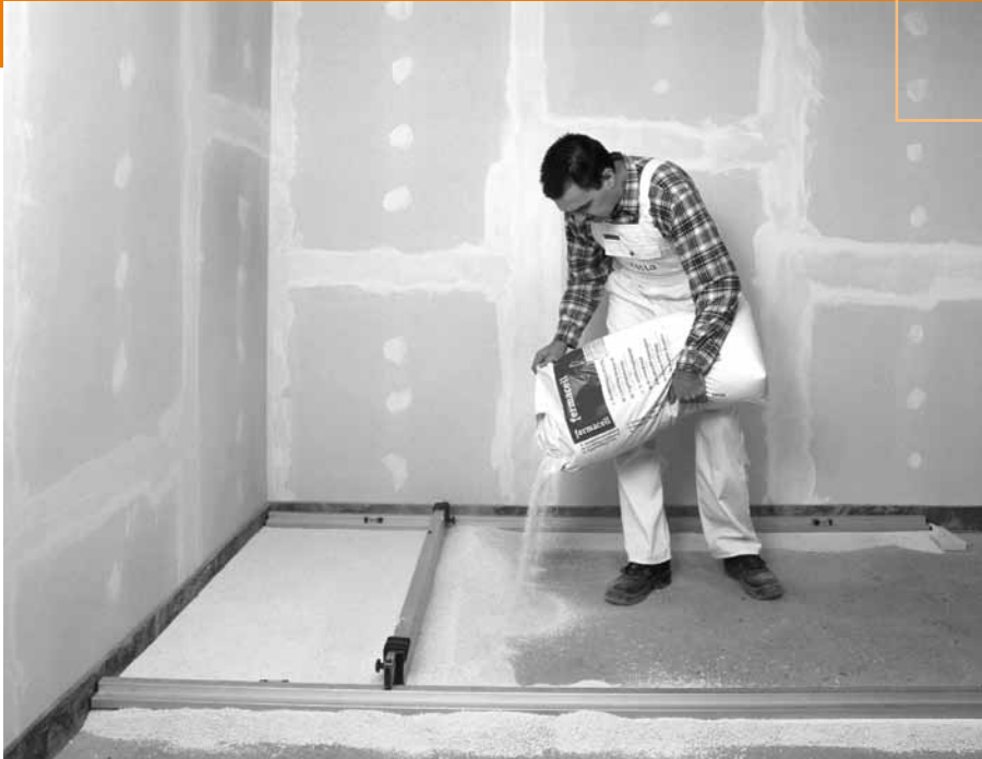
Einsatz der FERMACELL Ausgleichsschüttung zum Nivellieren von unebenen Böden. Hier im Bild die Verarbeitung mit dem Abziehlehrenset.
