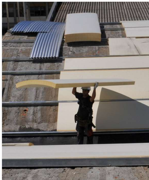
Pannelli curvi fresati - Copertura stabilimento industriale - Roma
