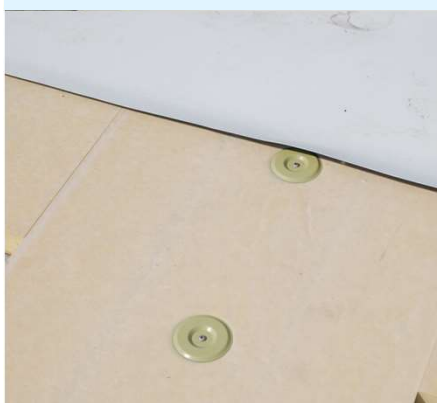
Cool Roof - Membrane sintetiche e fissaggio a induzione Struttura commerciale - San Vitaliano (NA)
