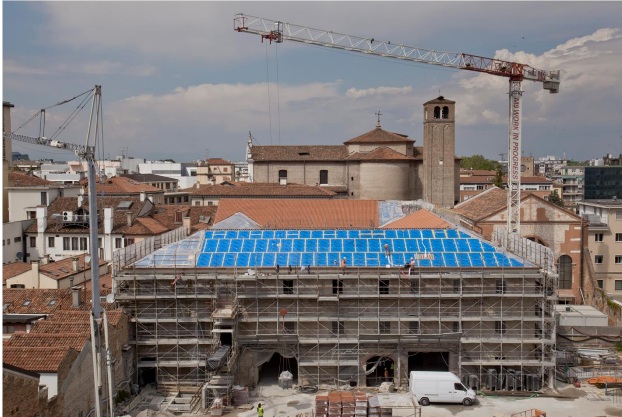
Isolamento di coperture ventilate- Museo Multimediale del '900 (M9) – Mestre (VE)
