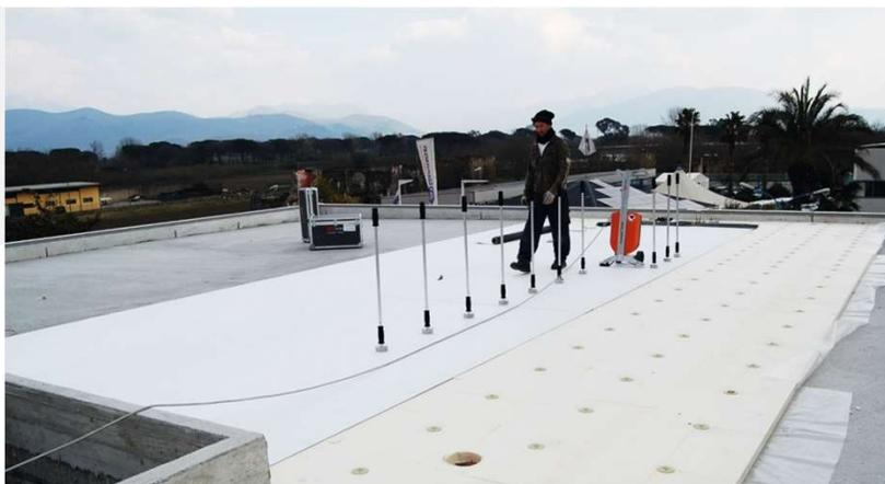
Cool Roof - Membrane sintetiche e fissaggio a induzione
