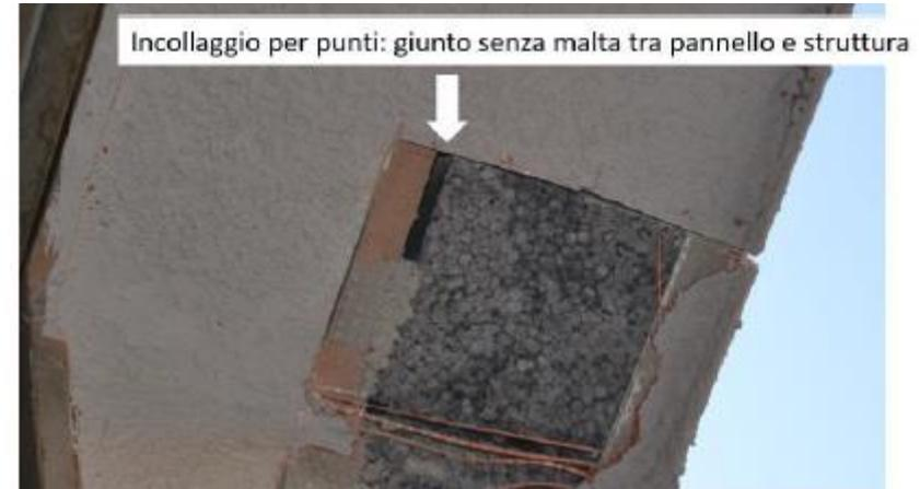
Incollaggio per punti: giunto senza malta tra pannello e struttura
