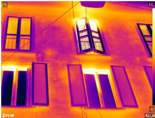
Ponti termici strutturali
