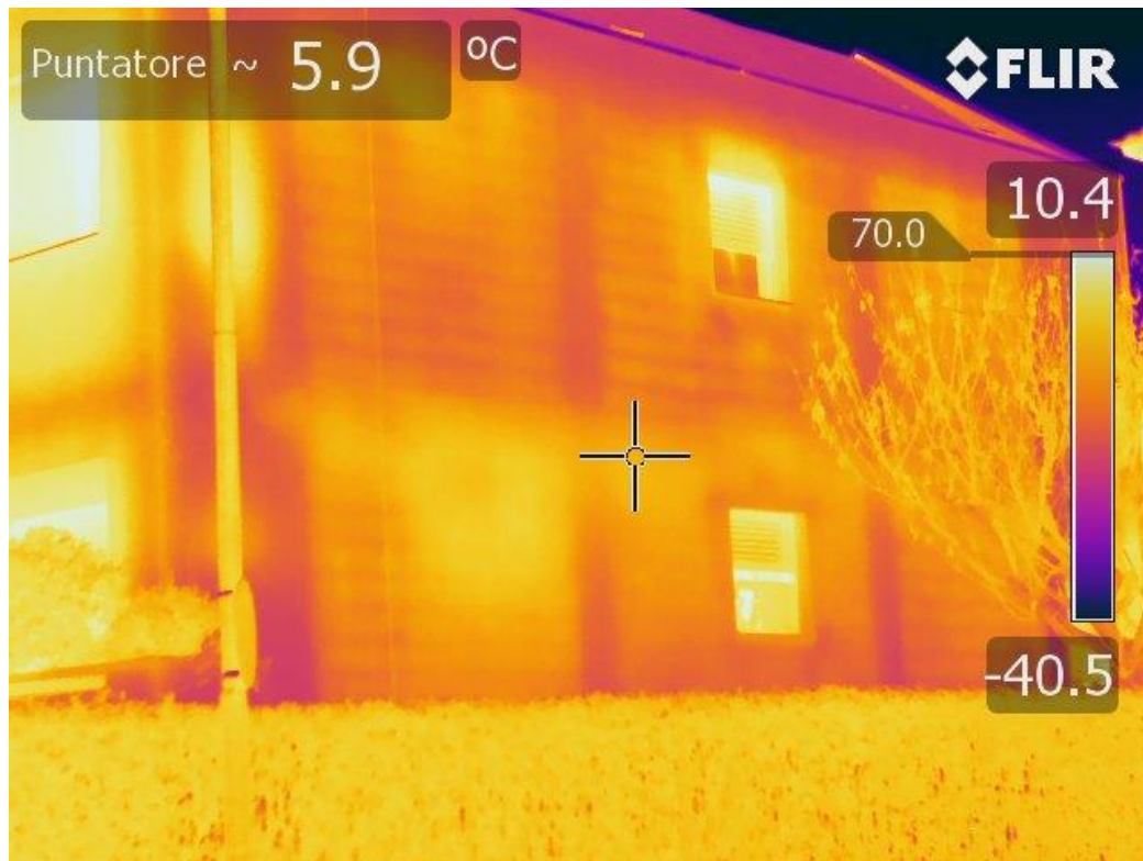
Tamponatura e struttura a telaio
