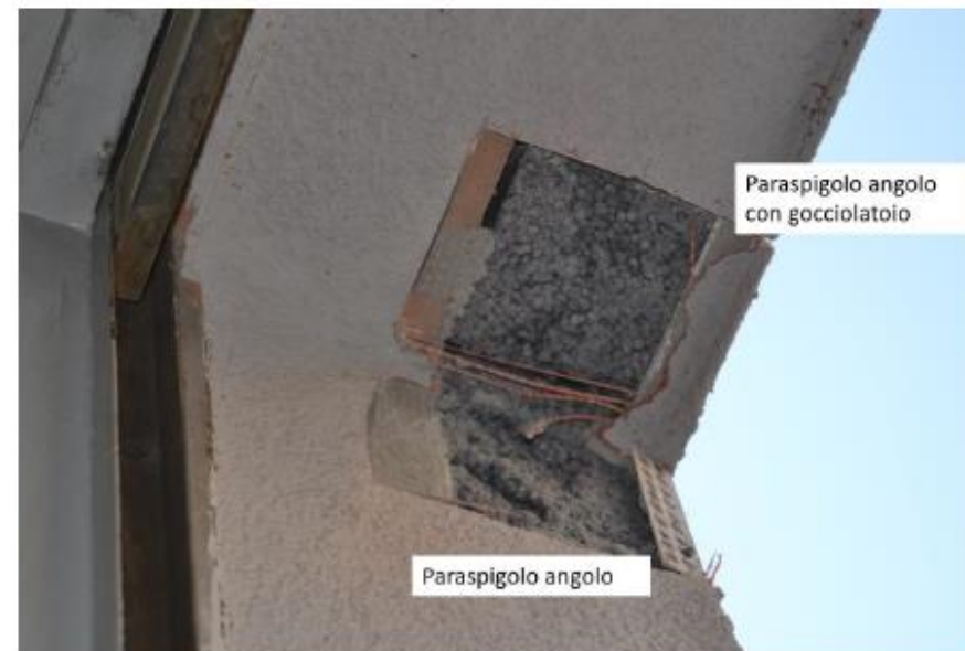
Esempio di valutazione della presenza del paraspigolo e del paraspigolo con gocciolatoio (punti 6 e 7)
