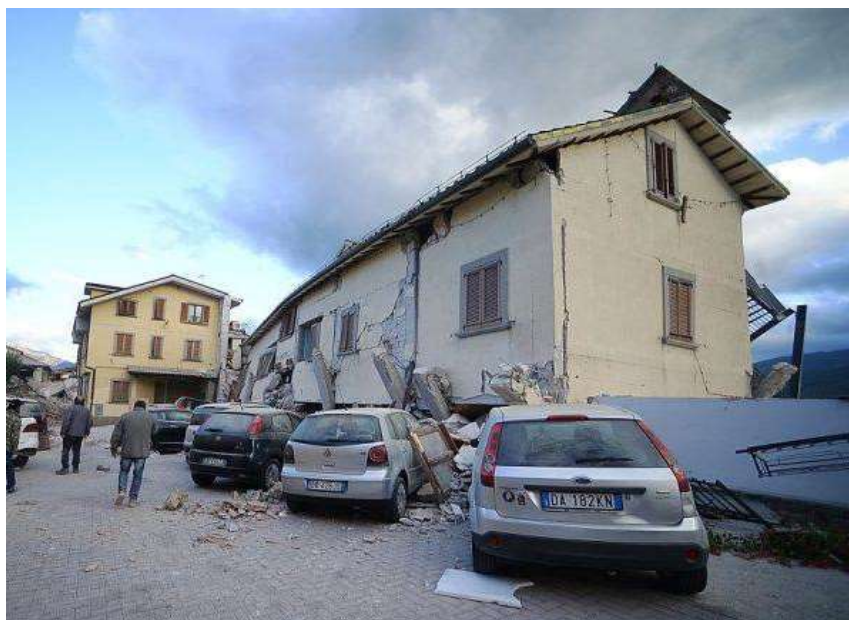
Palazzina residenziale – edificio a telaio in c.a. con tamponamento in AAC Hotel Roma – edificio a telaio in c.a. con tamponamento tradizionale
