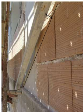
prospetto 1 Tolleranze di planarità del supporto (Fonte DIN 18202:2013, prospetto 3)
